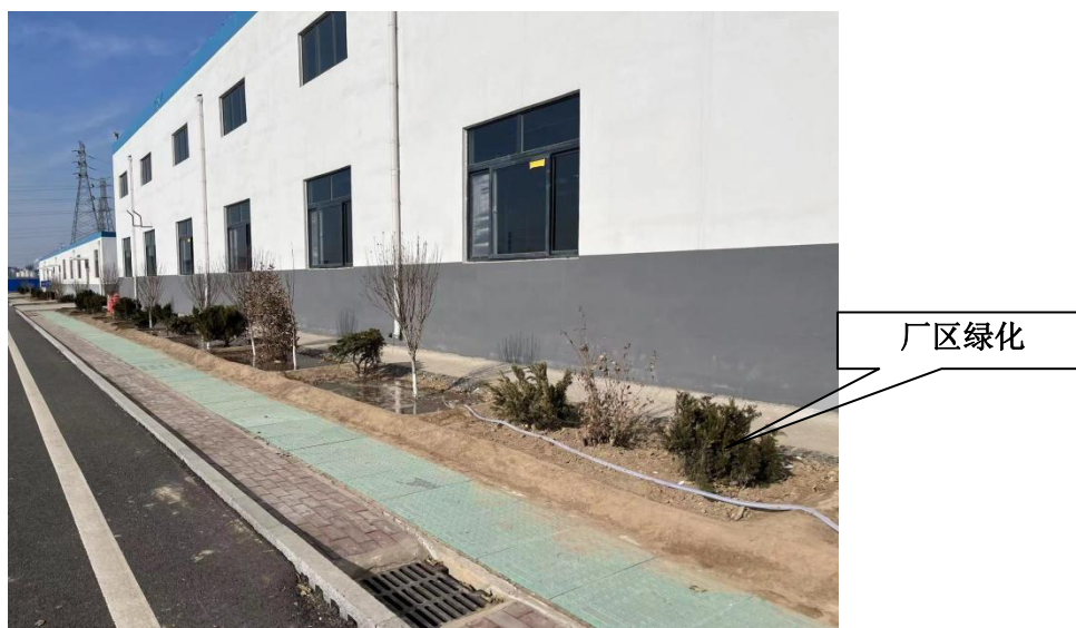
图 4.2-9 项目所在厂区绿化情况
