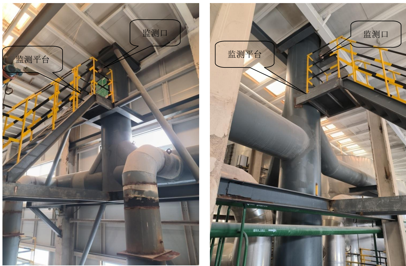
图 4.1-5 气粉机尾气治理设施及排气筒实际建设情况图
